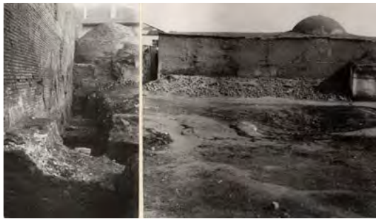
Medresede yapılan kazı ve hafriyat çalışmaları S. Ülgen)
