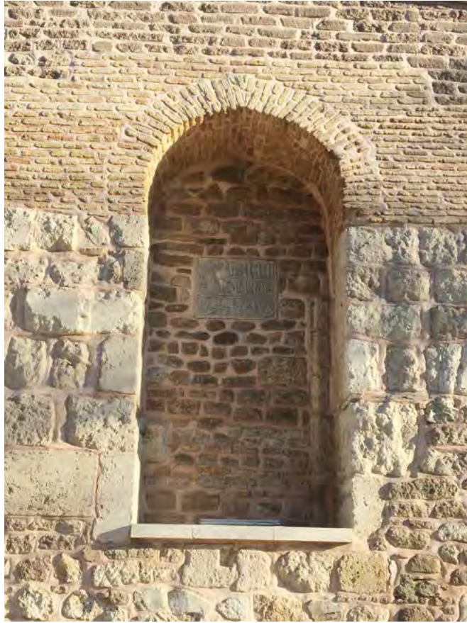
6. Fotoğraf: Konya Alâeddin Camisinin batı cephesindeki sultan mahfilinin özgün giriş olması muhtemel niş ve kitabenin görünüşü.
