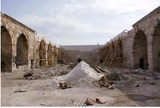
Kervansarayda yapılan restorasyon çalışması (VGM Arşivi)
