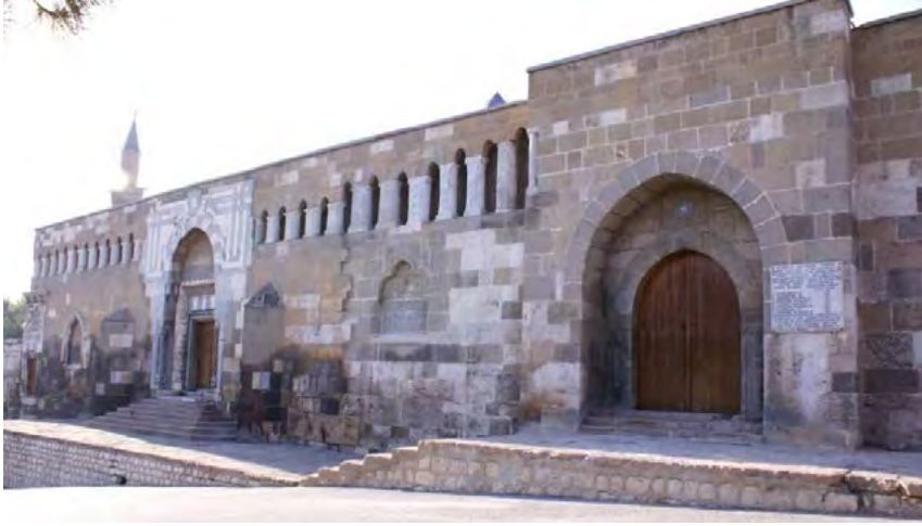
Kuzey cephe görünümü
