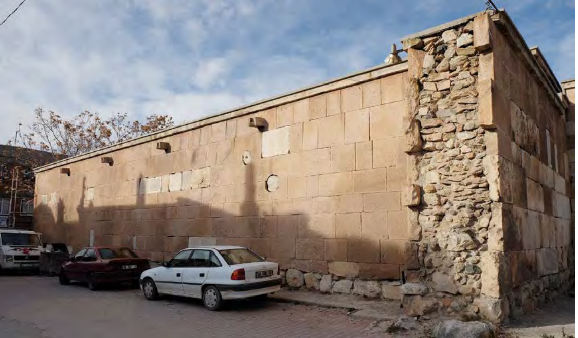
2-Konya-Akşehir yolu, Kadın Han, avlu duvarı kalıntısı (yazar)
