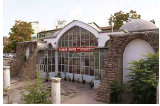
Medresenin onarım öncesi durumu
