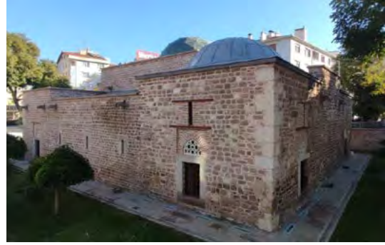
Medresenin güney ve batı cephe görünümü
