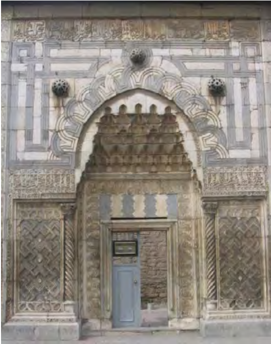
Taç kapı görünümü
