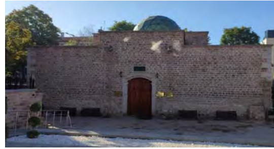
Medrese giriş cephesi
