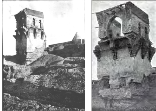
Köşkün yıkılmadan önceki durumu (Van Berchem'den)
