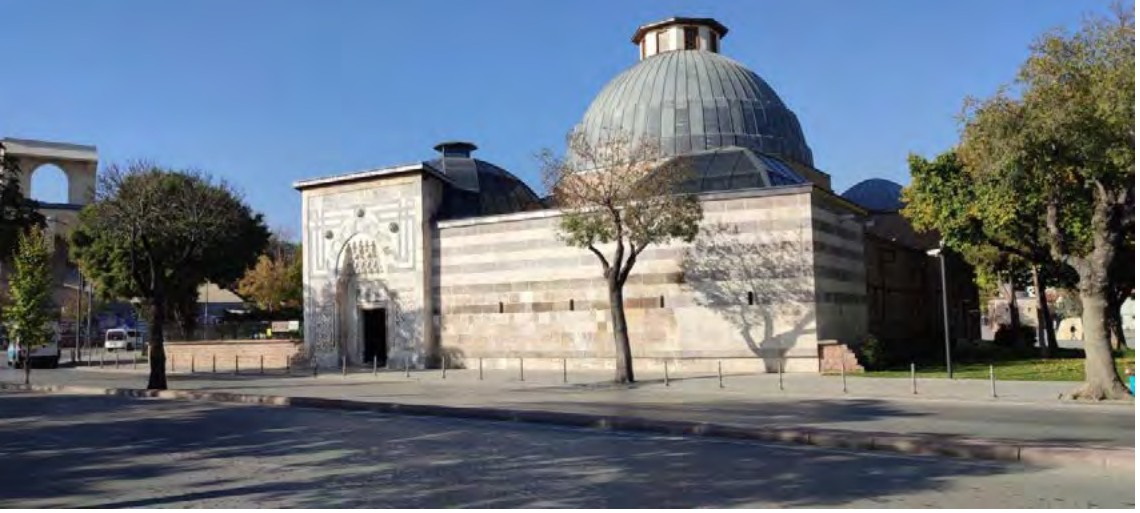
Medrese giriş cephesi
