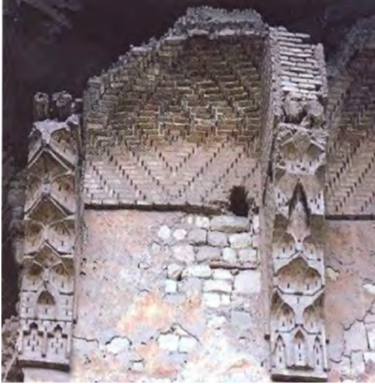
Res. 6: Konya, Kılıç Arslan Köşkü, tuğla konsollar.
