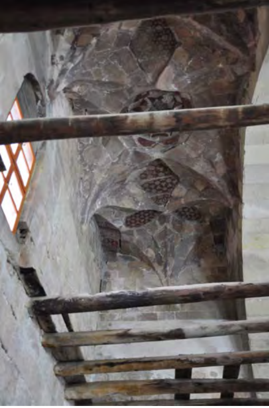
11. Fotoğraf: Divriği Ulu Camisi, bey mahfilinin döşeme kirişleri ve tonoz örtüsünün görünüşü.
