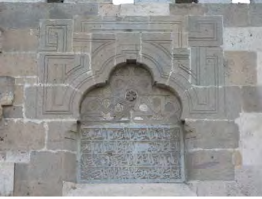
Fotoğraf 18. Caminin avlu kuzey duvarındaki İzzeddin Keykâvus Türbesi'ne ait kitabe
