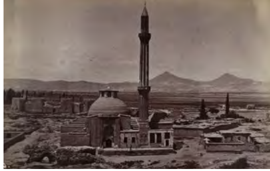
Zindankale'nin yıkılmadan önceki durumu (J. Haynes-1887).
