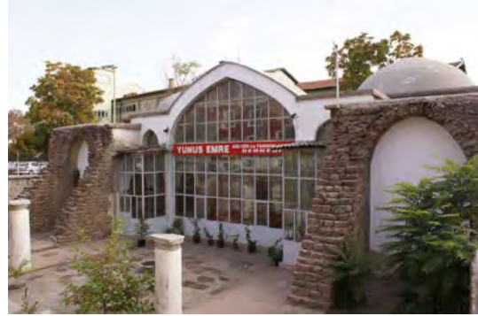
Medresenin onarım öncesi durumu
