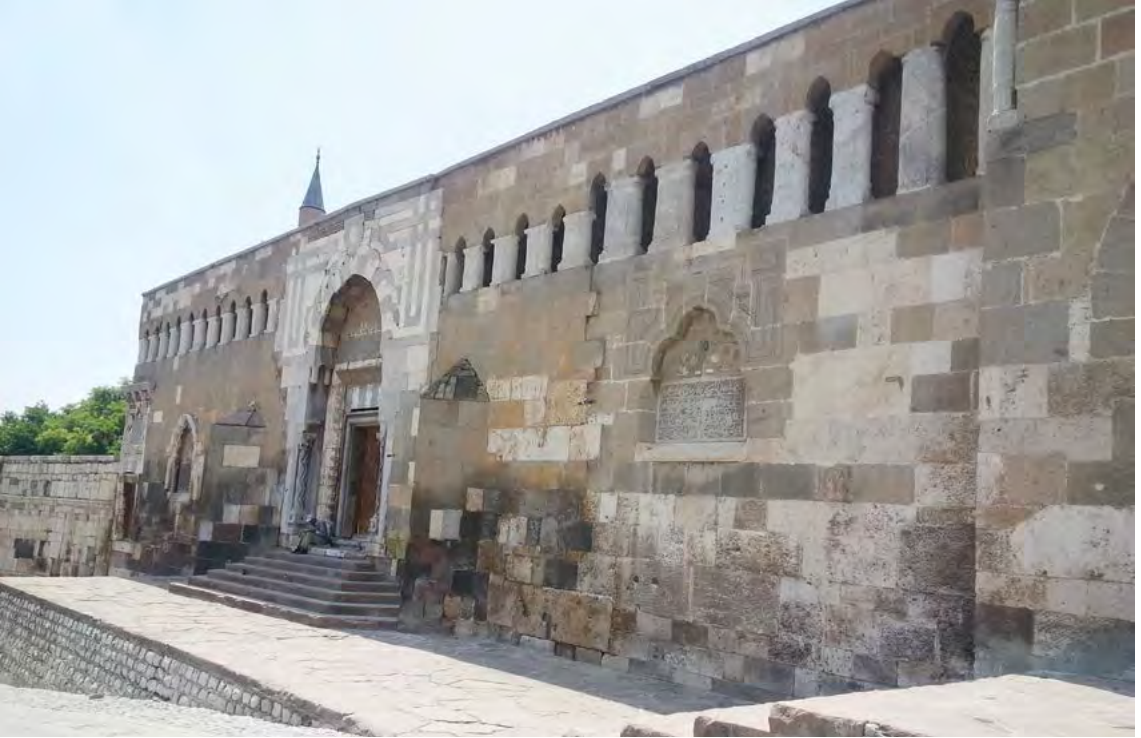
8- Konya, Alâeddin Camii, avlu duvarı, şehir tarafı (yazar)
