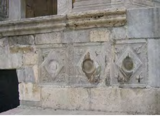
Fotoğraf 11-12. Türbedeki devşirme malzemeler
